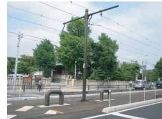
写真2. センターポール形式の架線。
